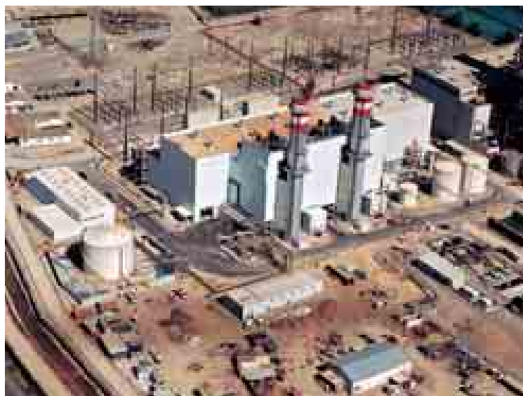
La maquinaria está ligada de forma definitiva al funcionamiento de los inmuebles de características especiales. En la foto, una instalación de generación eléctrica de ciclo combinado. (Foto Iberdrola).
